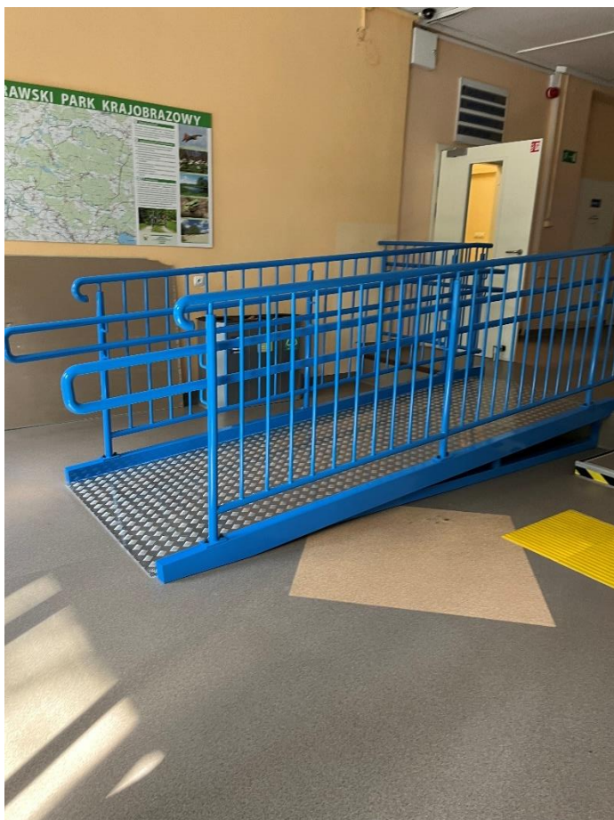
Zdjęcie nr 6 – pochylnia w strefie wejściowej do budynku
