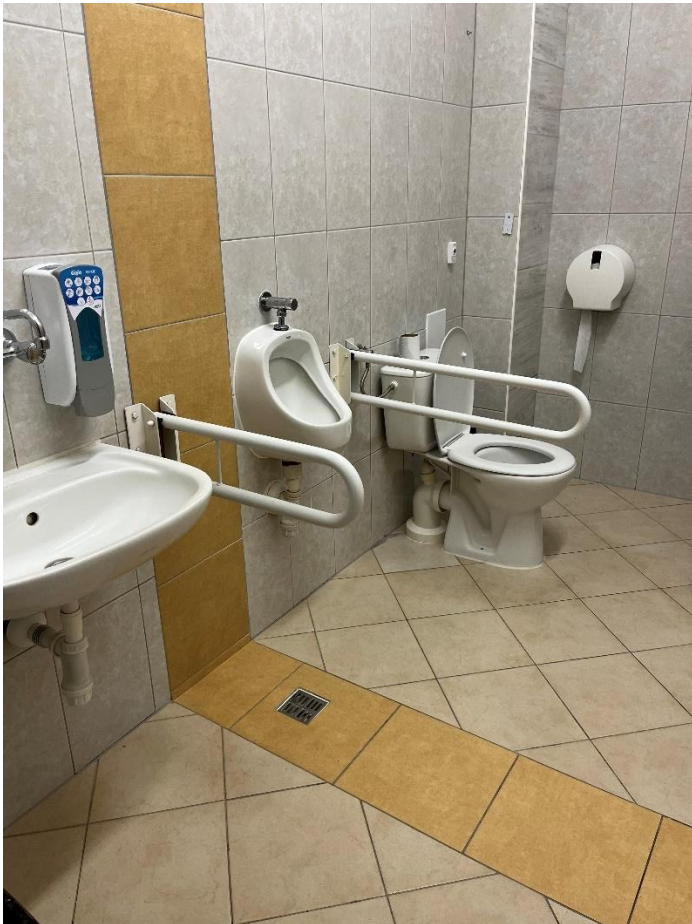
Zdjęcie nr 7 – jedna z toalet w budynku
