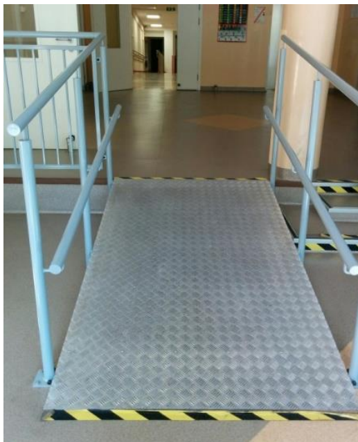
Zdjęcie nr. 2 Pochylnia nietrzymająca parametrów standardów dostępności
