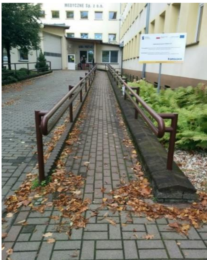
Zdjęcie nr. 1 Pochylnia nietrzymająca parametrów standardów dostępności
