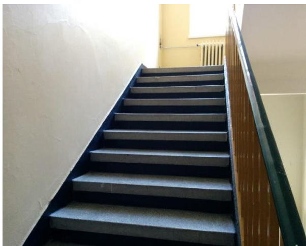
Zdjęcie nr. 6 Przykładowa poręcz przyschodowa – wysokość 1,14 cm
